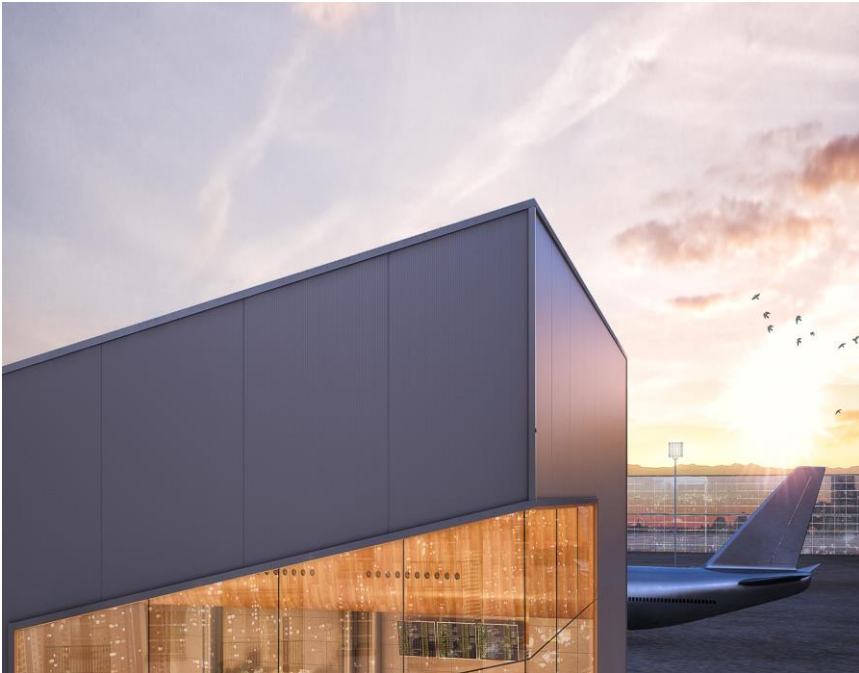
Aeroporto com painel de espuma de poliuretano
